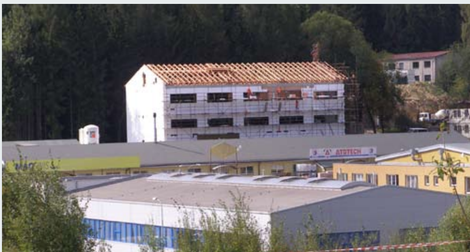
Hrubá stavba technického centra
