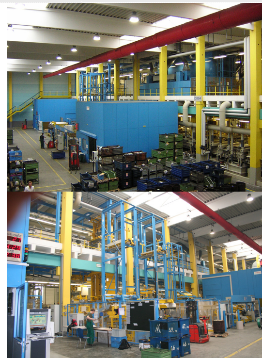
Nabehandelinginstallatie van WHW Hillebrand
